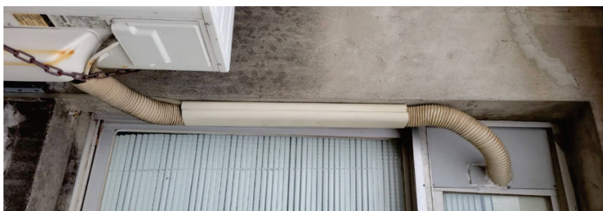
圖 2 室外銅管加裝管槽保護
