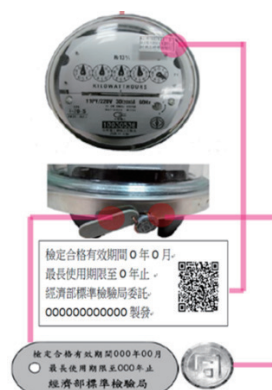
圖 1 檢定合格電表應貼有檢定合格有效期間標示及「同」字檢定合格鉛封
