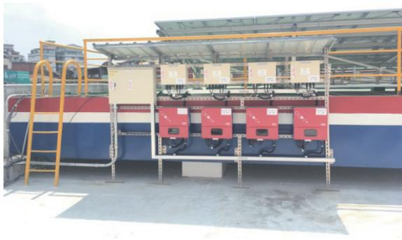
圖10 太陽光電變流器現場情形
