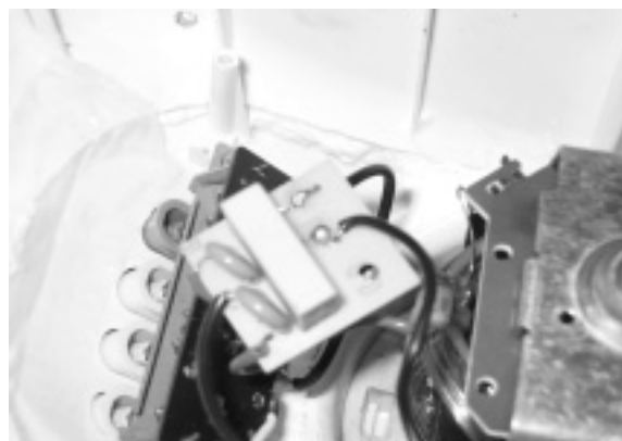
圖 6 拔除共模電磁干擾濾波器電感 Ly 後濾波器基板情形
