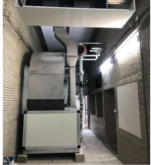
圖 4-66、空調系統施作
