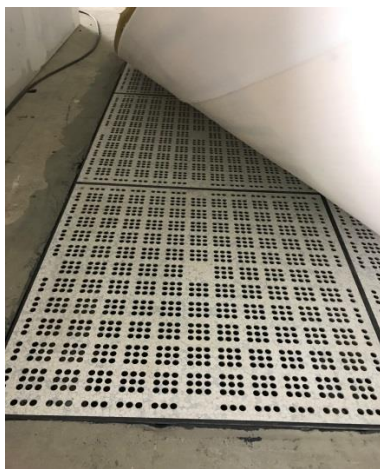
圖 4-70、高架地板鋪設
