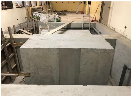
圖 4-58、完成水泥塊灌漿作業
