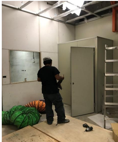
圖 4-67、完成隔間庫板與幫浦室工程
