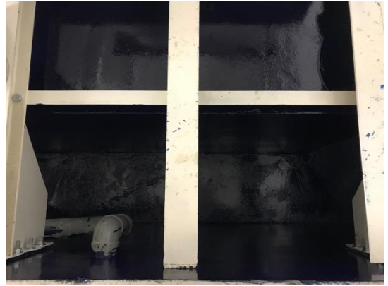
圖 4-69、筏基底部防塵處理
