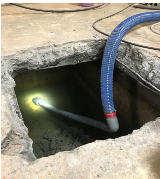
圖 4-51、實驗室地板開挖與筏基抽水作業
