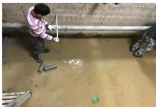
圖 4-53、筏基排水管路重新架設
