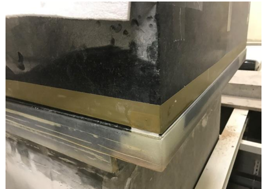
圖 4-64、水泥塊與花崗岩樹脂接合補強作業
