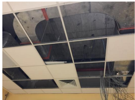
圖 4-50、B12 實驗室天花板拆除作業
