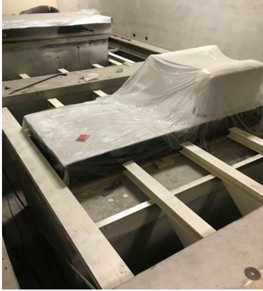
圖 4-65、完成鋪設高架地板支撐鋼樑作業
