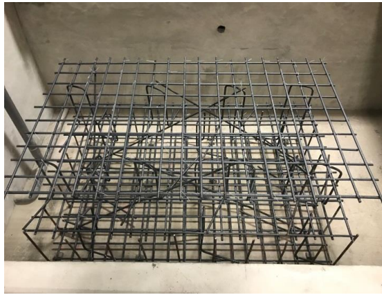
圖 4-56、水泥塊基礎鋼筋綁匝
