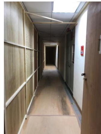
圖 4-48、施工隔離走道
