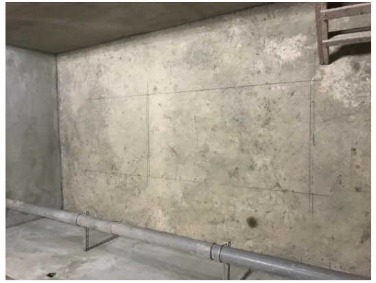
圖 4-55、水泥塊平面尺寸定位(彈線)放樣
