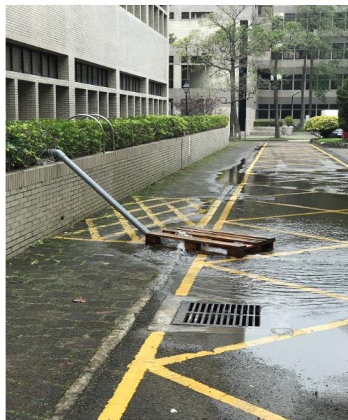
圖 4-51、實驗室地板開挖與筏基抽水作業
