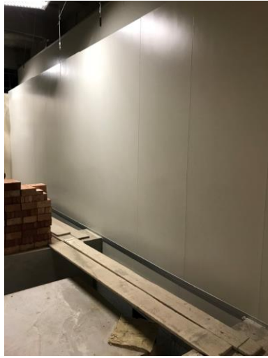
圖 4-60、迴風牆庫板架設
