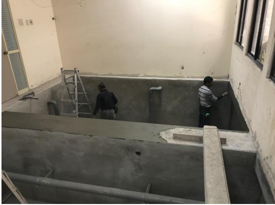
圖 4-54、筏基平整修補
