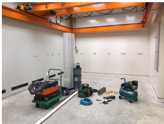
圖 4-72、完成 XPS XRF 區域天車架 設
