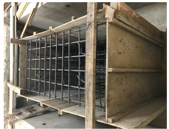
圖 4-57、灌漿模板架設
