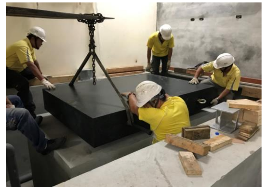
圖 4-63、完成花崗岩定位與接合作業
