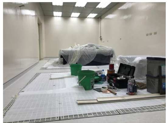
圖 4-73、完成氣源、電源與照明安裝
