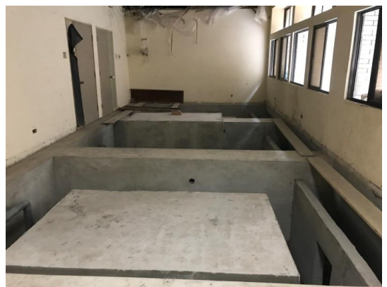
圖 4-59、完成右側迴風牆面地基灌漿作業
