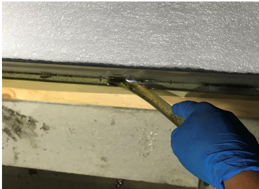
圖 4-64、水泥塊與花崗岩樹脂接合補強作業
