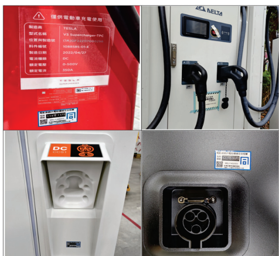
圖 2 充電樁檢定合格印證附加位置實際案例
