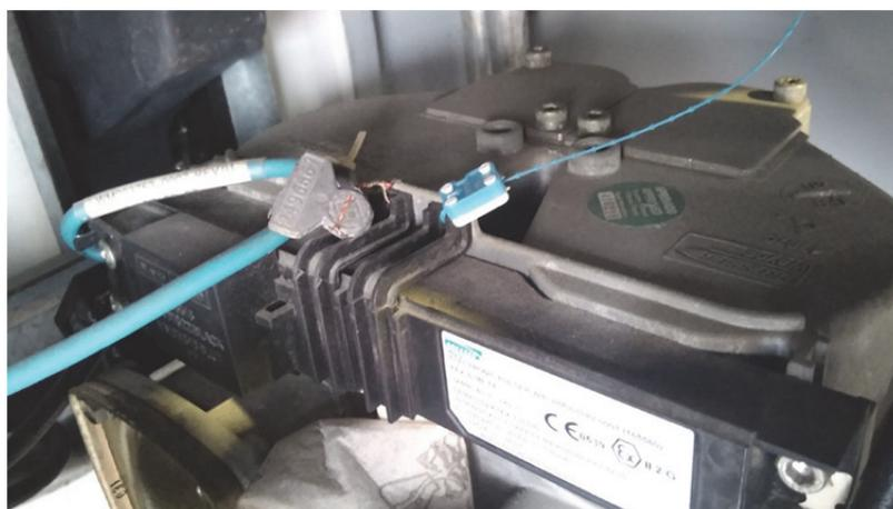
圖 4 油量計塑膠封印實際使用情形示意圖
