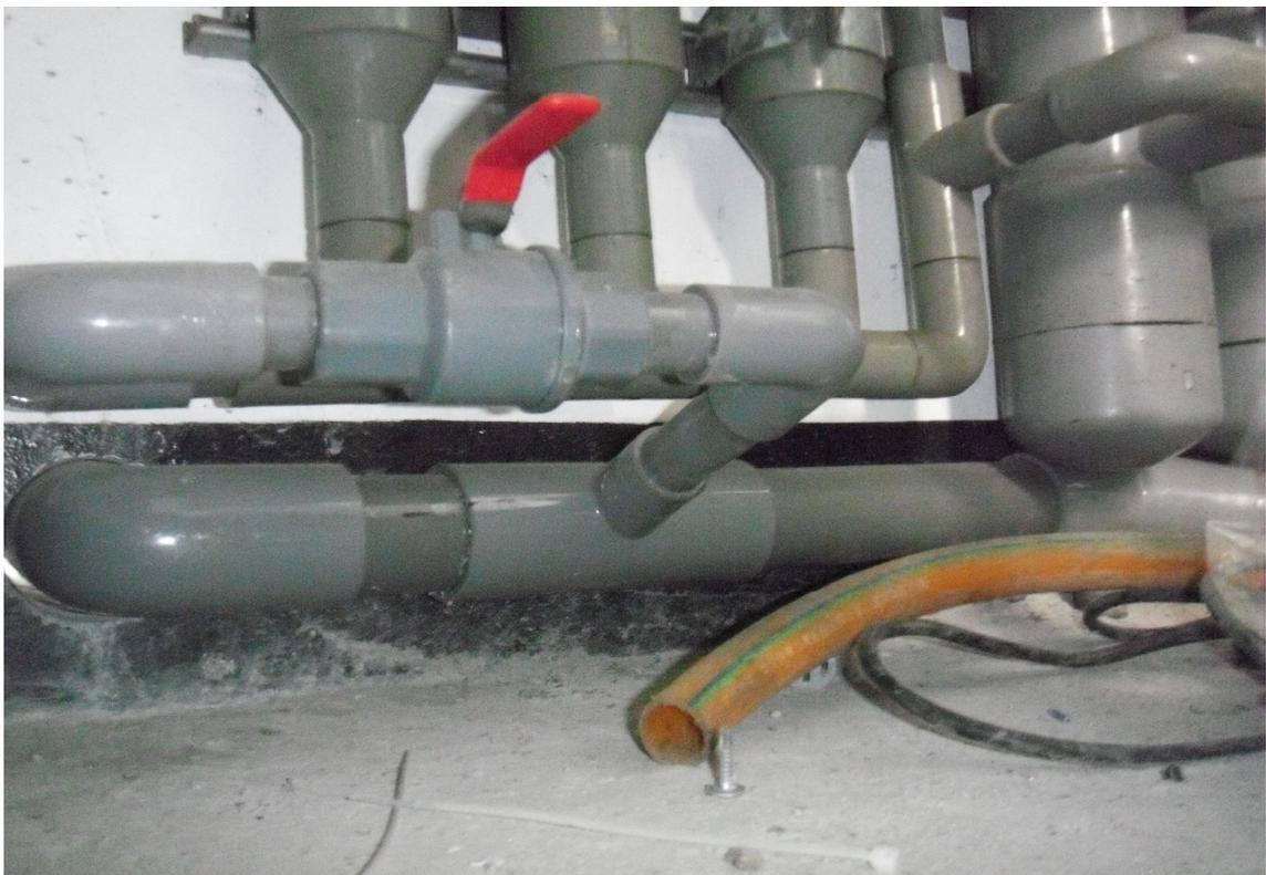
圖10：深層海水監測系統檢測管及排水管
