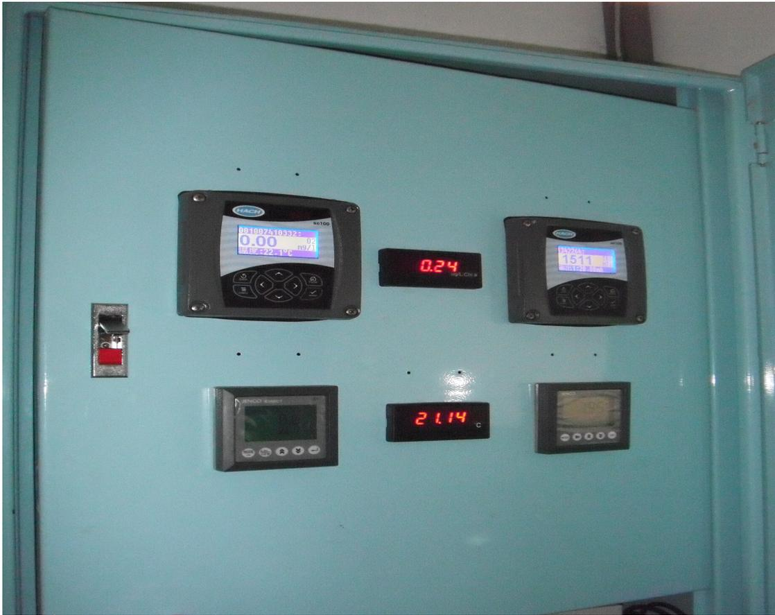
圖9：深層海水監測系統監測元件集中鐵箱
