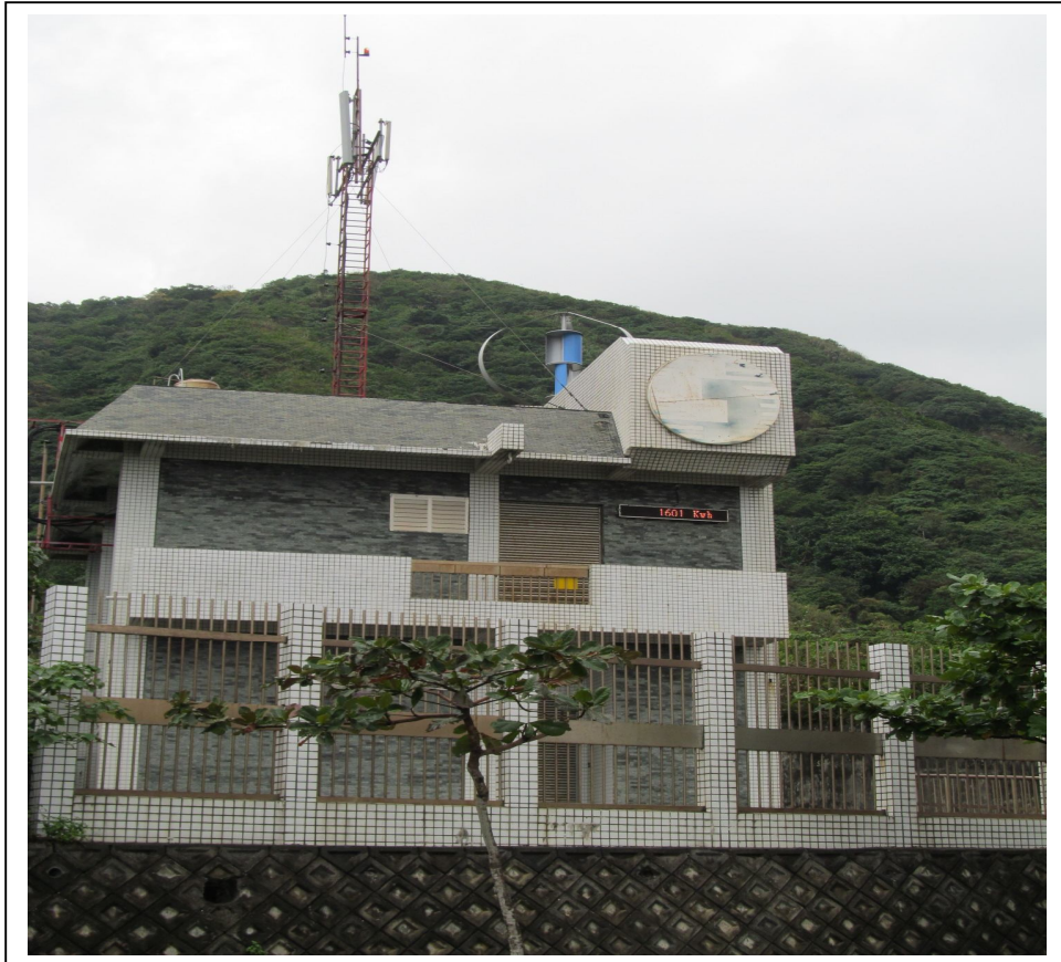
圖8 中華電信鹽寮風力機 LED 顯示1601 KWh (2年期間)
