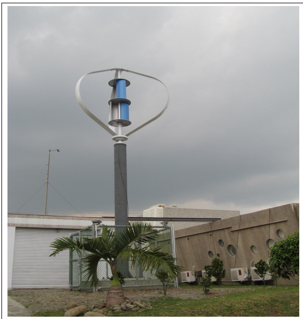
圖1 風力機一以纜線經H鋼連接化工實驗室
