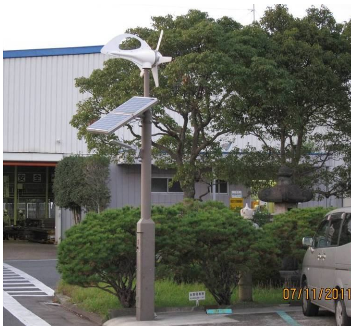
圖 11 AURA 1000 小型風力機搭配太陽光電模組
