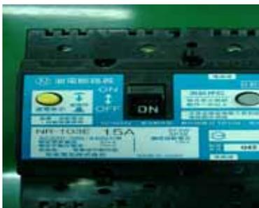
圖二 漏電斷路器外觀
