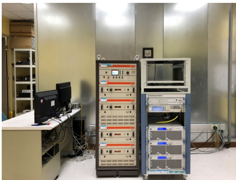
圖 74、(0.1-500) MHz 橫電磁波室高電磁場強度量測系統架設圖
