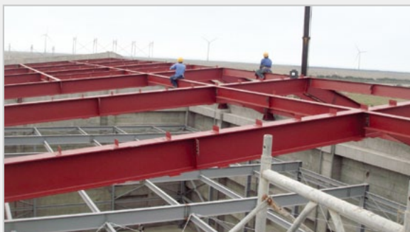
▲ 建築物屋頂鋼構施工完成之後，營繕課郭文雄就又多了一項體力及膽力的大考驗，就是在離地將近20公尺(相當於7層樓高)走動進行工程監督。
