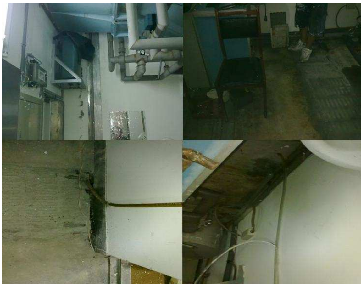
圖 1.11 地下室校正實驗室外面漏水改善施工圖
