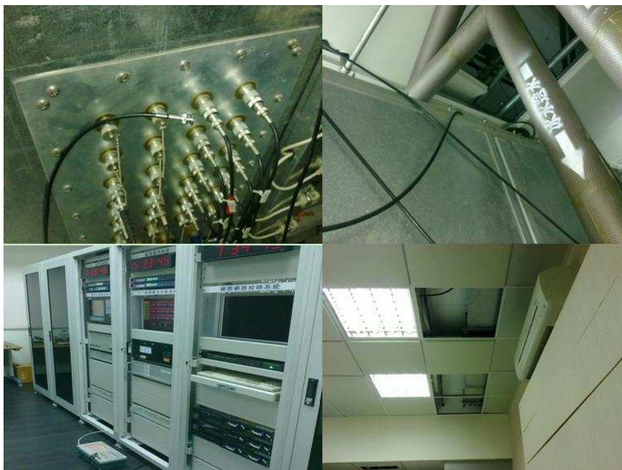
圖 1.14 信號線佈放及接頭製作施工圖
