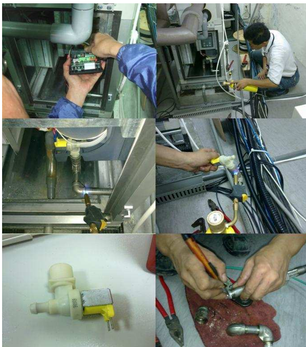
圖 1.7 標準件室 C 室加濕器系統施工圖
