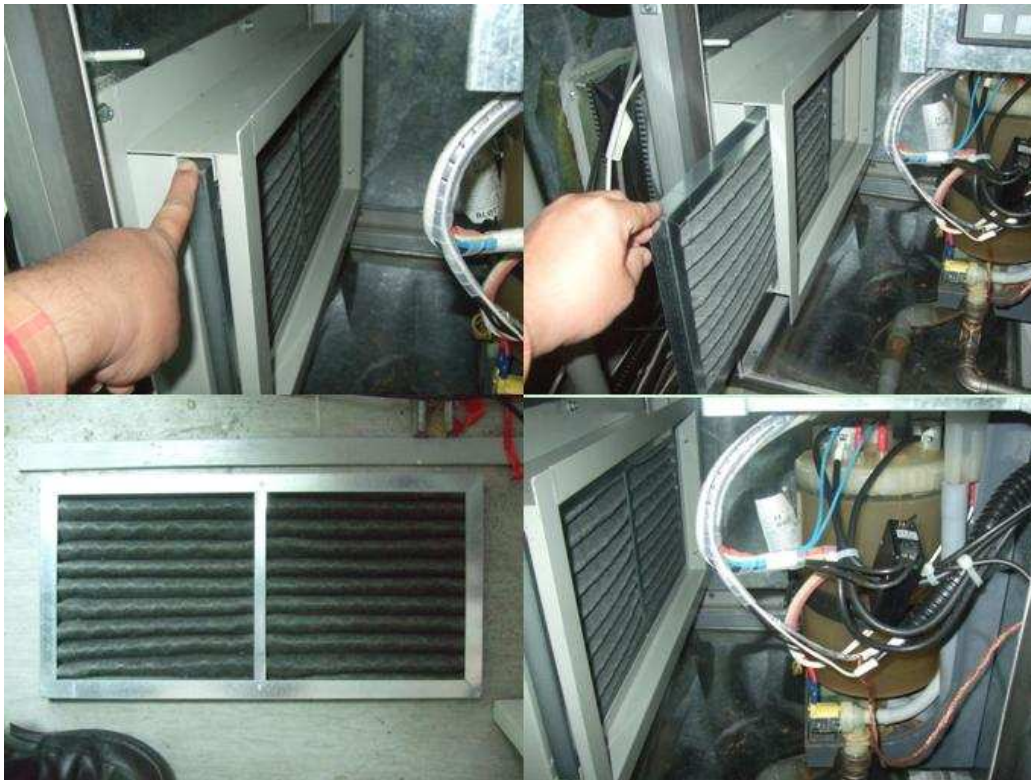
圖 1.8 標準件室 B 室濾網清洗更換圖
