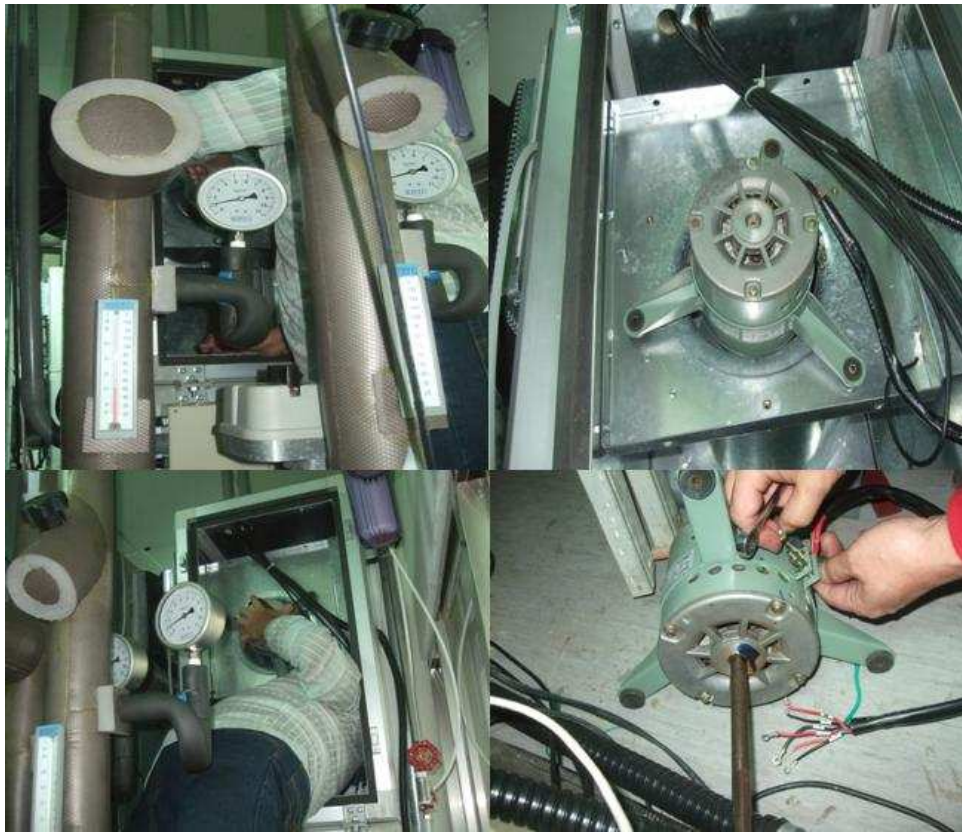
圖 1.9 標準件室 B 室回風扇異音處理圖
