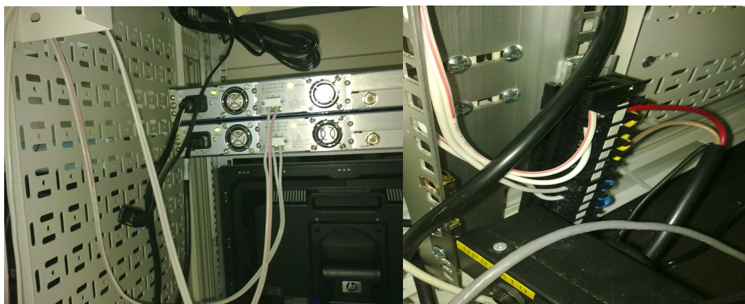
圖 1.13 AC/UPS/DC 電源設置施工圖
