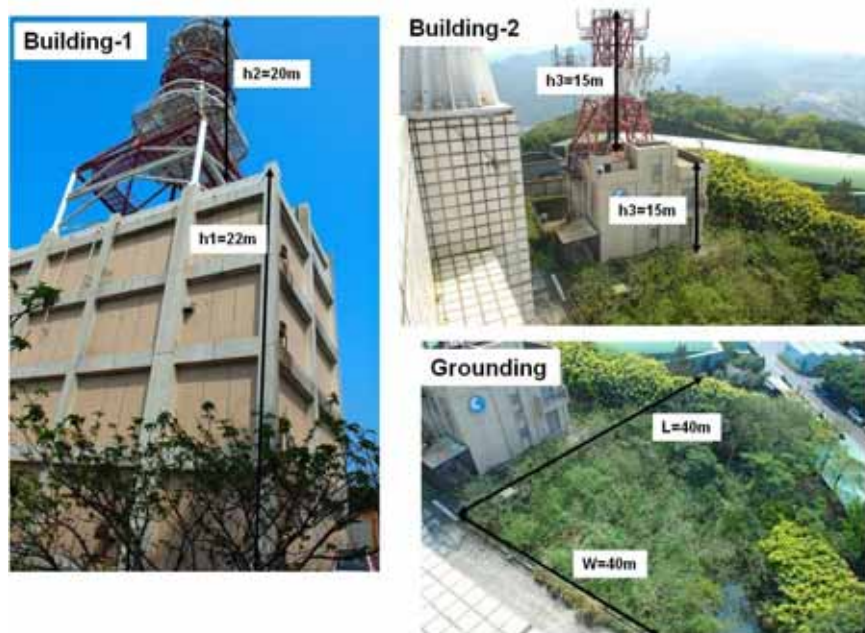
圖 2.3-3：桃園縣龜山鄉中華電信機房用地及天線場區
