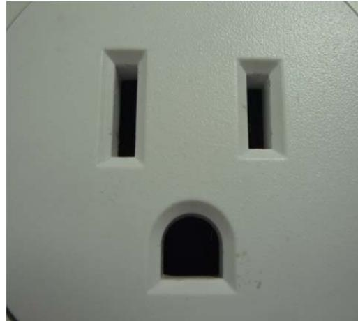
圖 7 插座為 2 極接地型（3 孔）
