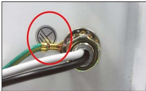
a. 燈具接地處的接地符號指示
