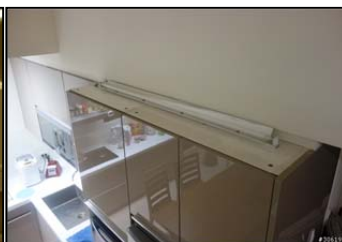
c. 直接擺木櫃上（黏貼固定）
