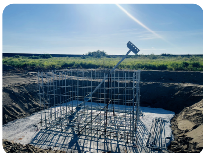
▲ 混凝土拉線座製作
