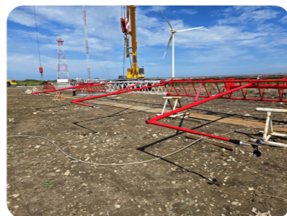
▲ 地面預組裝－組立儀器支架與測風儀器
