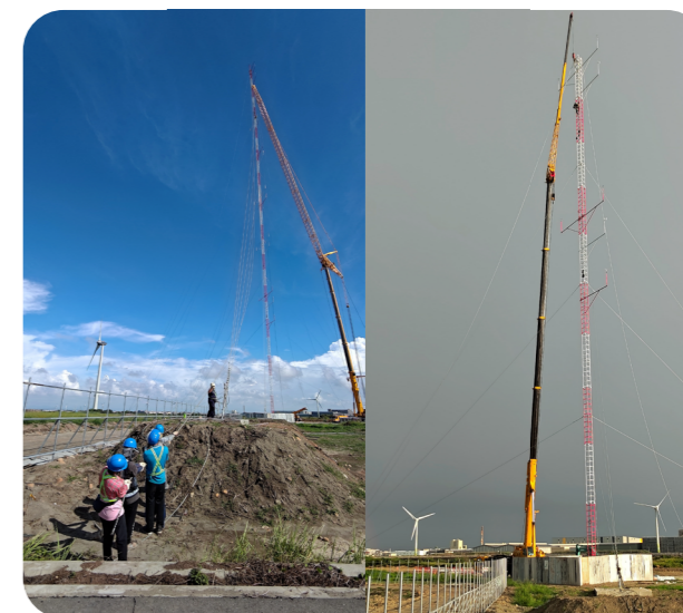
大型吊車吊裝 150 米測風塔 ▲
