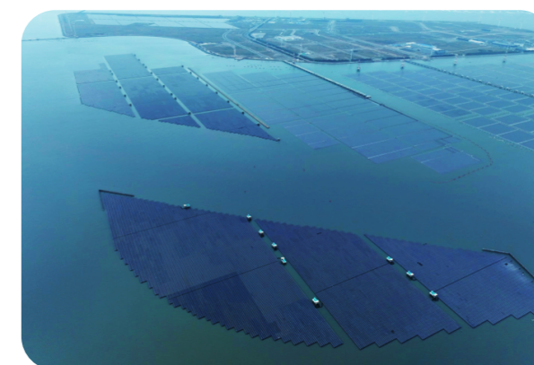
彰濱產業園區臨 6、臨 7 光電案場 ▲
