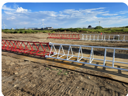
▲ 地面預組裝－塔節分段組立
