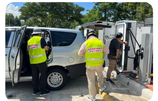
檢定機構人員現場執行充電樁檢定 ▲
