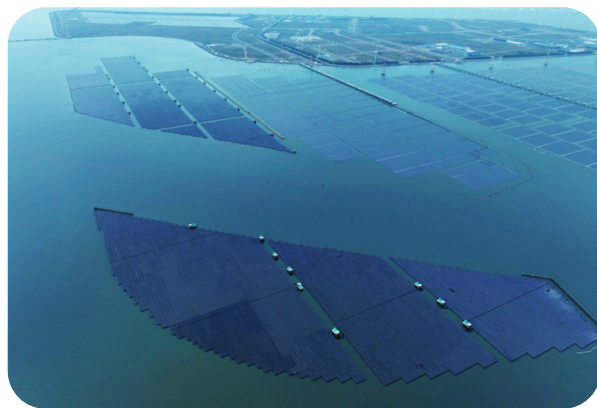
彰濱產業園區臨 6、臨 7 光電案場 ▲
