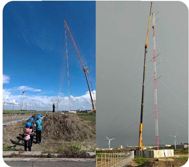
大型吊車吊裝150米測風塔 ▲
