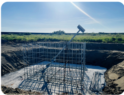
▲ 混凝土拉線座製作
