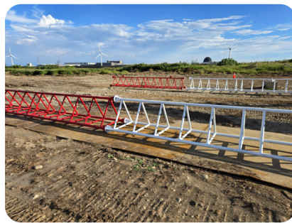
▲ 地面預組裝－塔節分段組立
