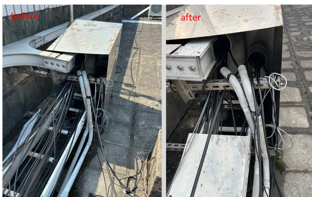
圖 32、完成頂樓集線巢整線
