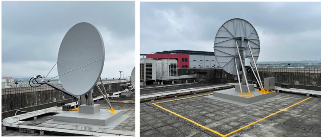
圖 24、TL01 衛星地面站實體完工圖
