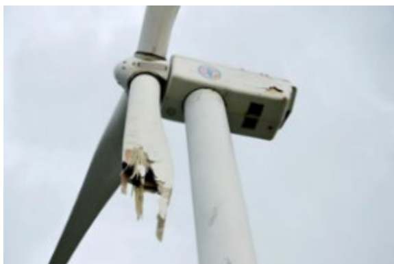
圖 4-1-8、風力發電機葉片損毀案例
