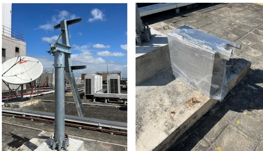
圖 28、衛星地面站 TL01 施工照
