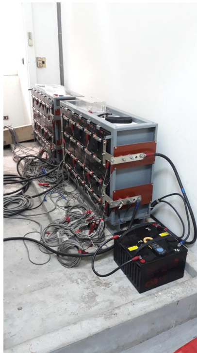
圖 3 、109 年直流電源系統放電測試施作情形
