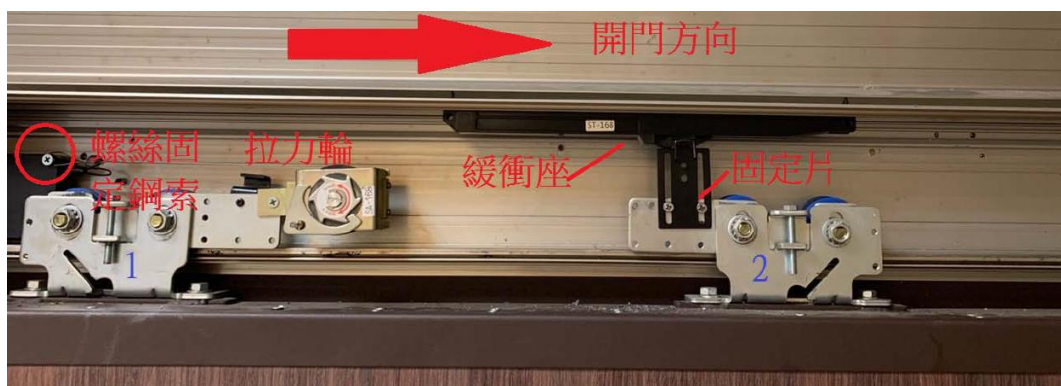
圖 2 橫拉門非電力驅動之拉力輪之安裝
