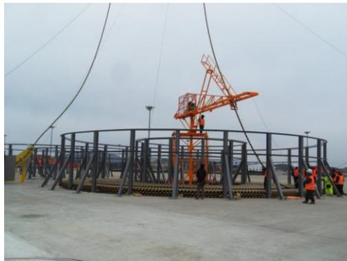
圖5 韓國樂星電纜公司(LS)之海底電纜機械捲繞試驗
