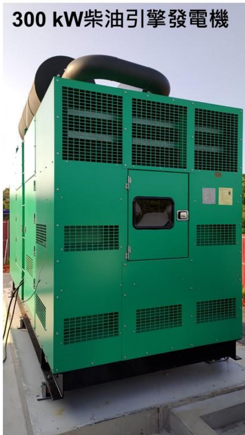
圖參-18、柴油引擎發電機、油箱與溢油堤現場圖
