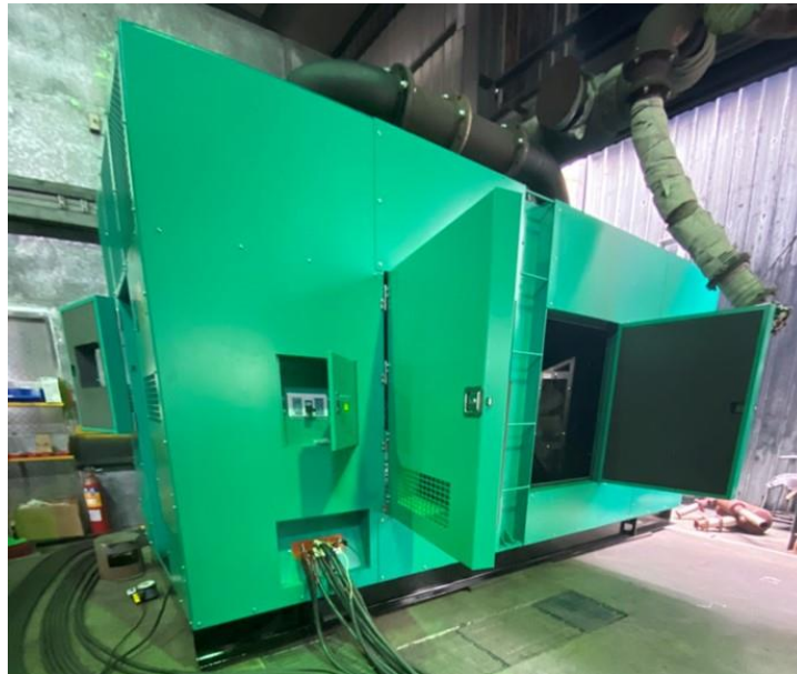
圖參-11、300 kW柴油引擎發電機組廠驗現場圖（送電開關）
