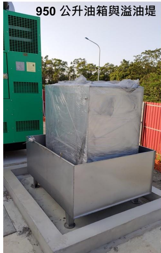
圖參-18、柴油引擎發電機、油箱與溢油堤現場圖
