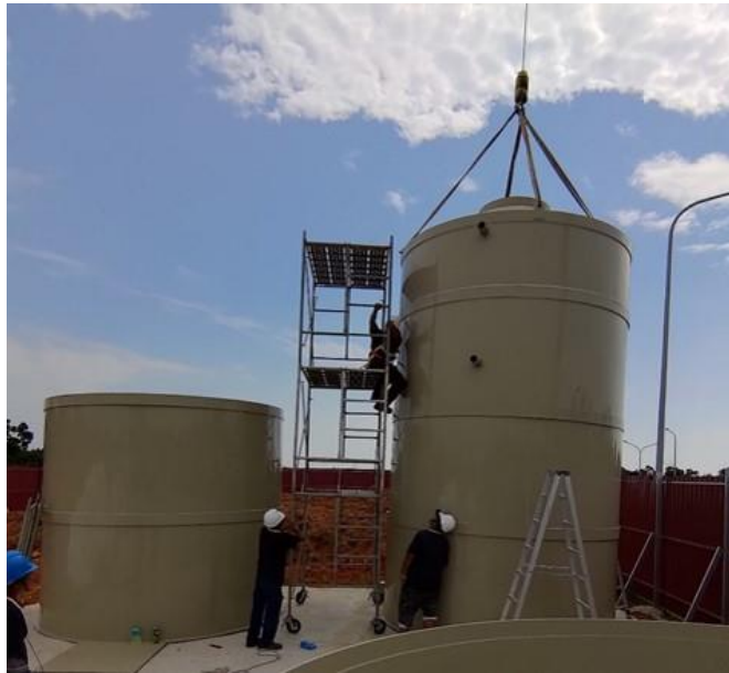
圖參-12、雙道洗滌塔廠驗現場圖
