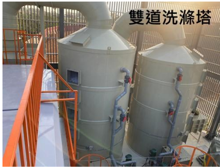
圖參-21、直立逆洗雙道式洗滌塔現場圖
