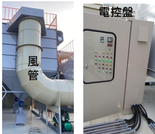
圖參-25、風管與電控盤現場圖
