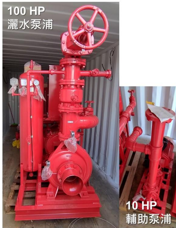
圖參-19、灑水泵浦與輔助泵浦現場圖
