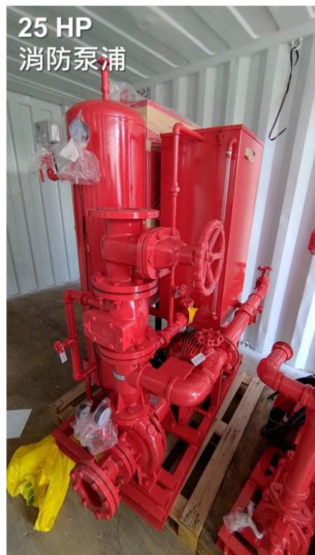
圖參-19、灑水泵浦與輔助泵浦現場圖
