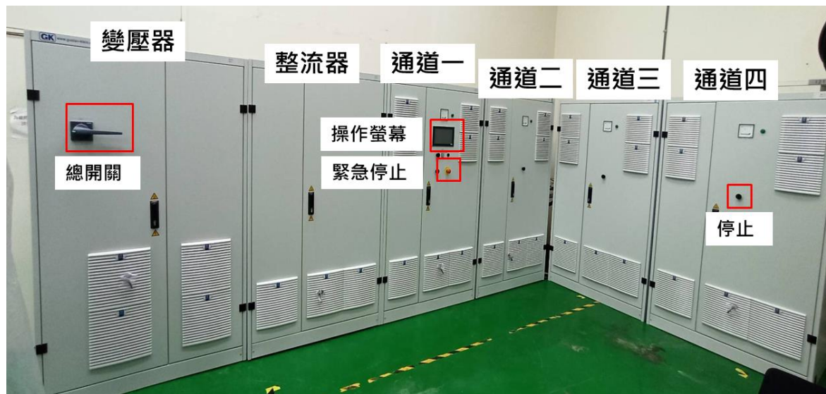
圖參-2、本案高壓電池充放電測試系統功能說明
