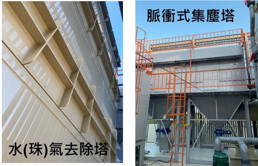
圖參-21、直立逆洗雙道式洗滌塔現場圖
