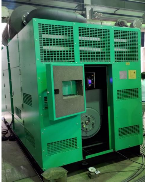
圖參-10、300 kW柴油引擎發電機組廠驗現場圖（操控面板）
