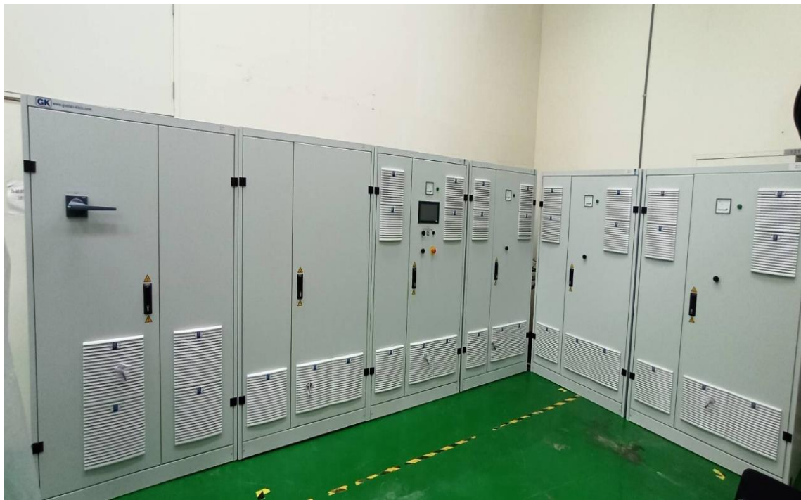
圖參-1、本案高壓電池充放電測試系統完工現場圖
