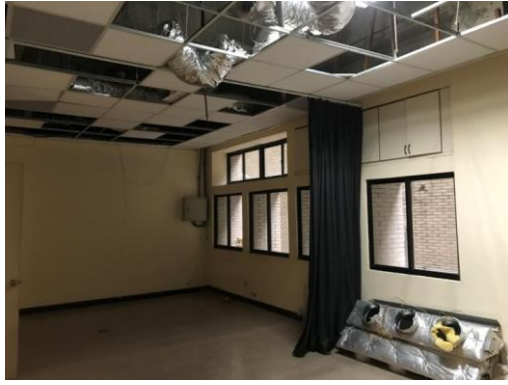
圖 3-2-12、實驗室天花板拆除作業
