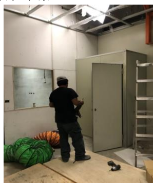
圖 3-2-30、隔間庫板與幫浦室工程
