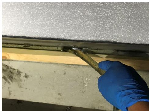
圖 3-2-27、水泥塊與花崗岩樹脂接合補強作業
