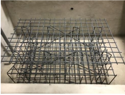
圖 3-2-19、水泥塊基礎鋼筋綁匹
