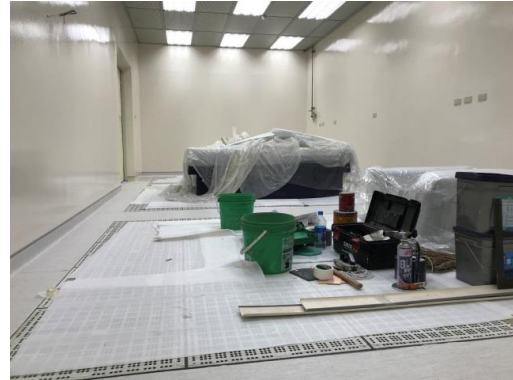
圖 3-2-36、氣源、電源與照明安裝
