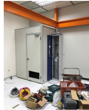
圖 3-2-37、新質量標準實驗室消防器材裝設
