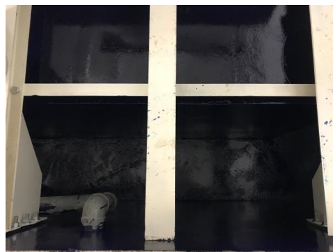
圖 3-2-32、筏基底部防塵處理
