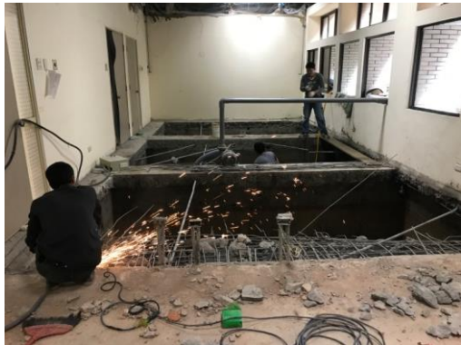
圖 3-2-15、地板拆除作業
