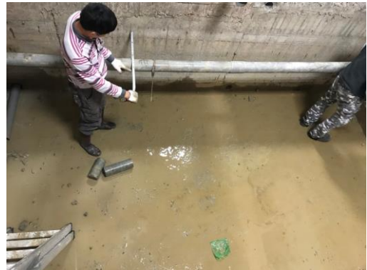
圖 3-2-16、筏基排水管路重新架設
