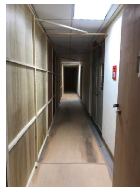
圖 3-2-11、施工隔離走道
