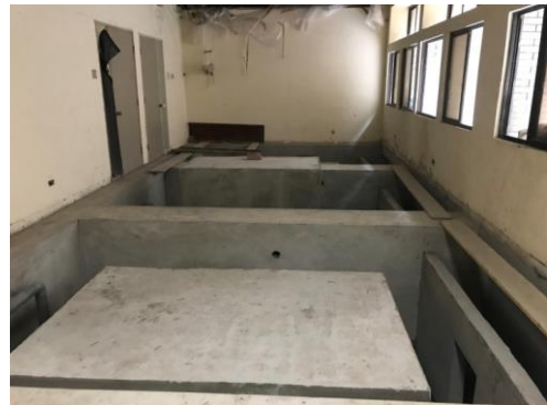
圖 3-2-22、右側迴風牆面地基灌漿作業
