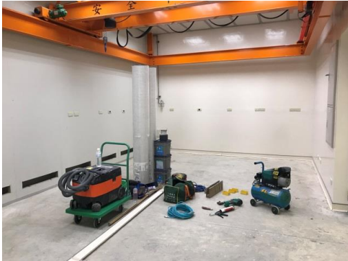
圖 3-2-35、XPS XRF 區域天車架設
