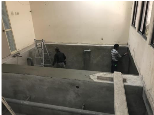
圖 3-2-17、筏基平整修補
