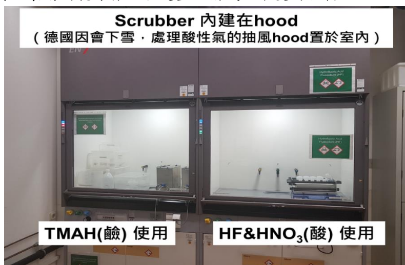
圖 5-4-3、酸性溶劑與鹼性溶劑擺放與操作設施設置現況(資料來源:德國 PTB)
