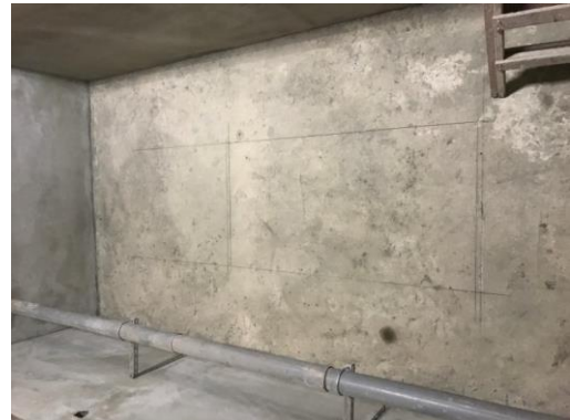
圖 3-2-18、水泥塊平面尺寸定位(彈線)放樣
