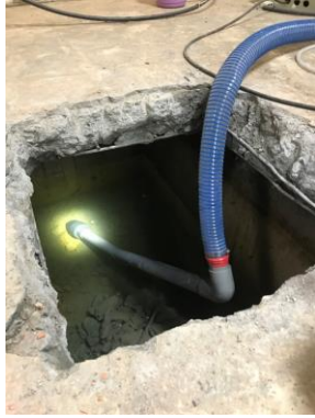
圖 3-2-14、實驗室地板開挖與筏基抽水作業
