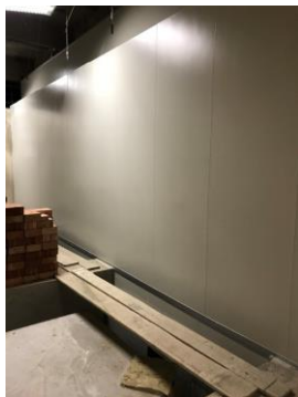
圖 3-2-23、迴風牆庫板架設
