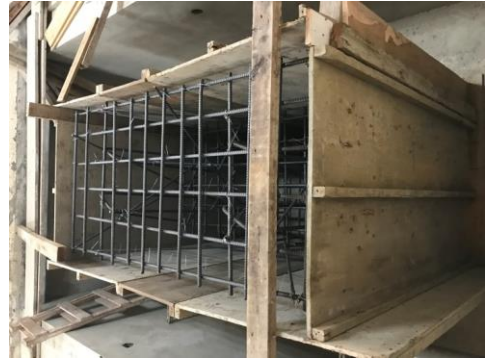
圖 3-2-20、灌漿模板架設
