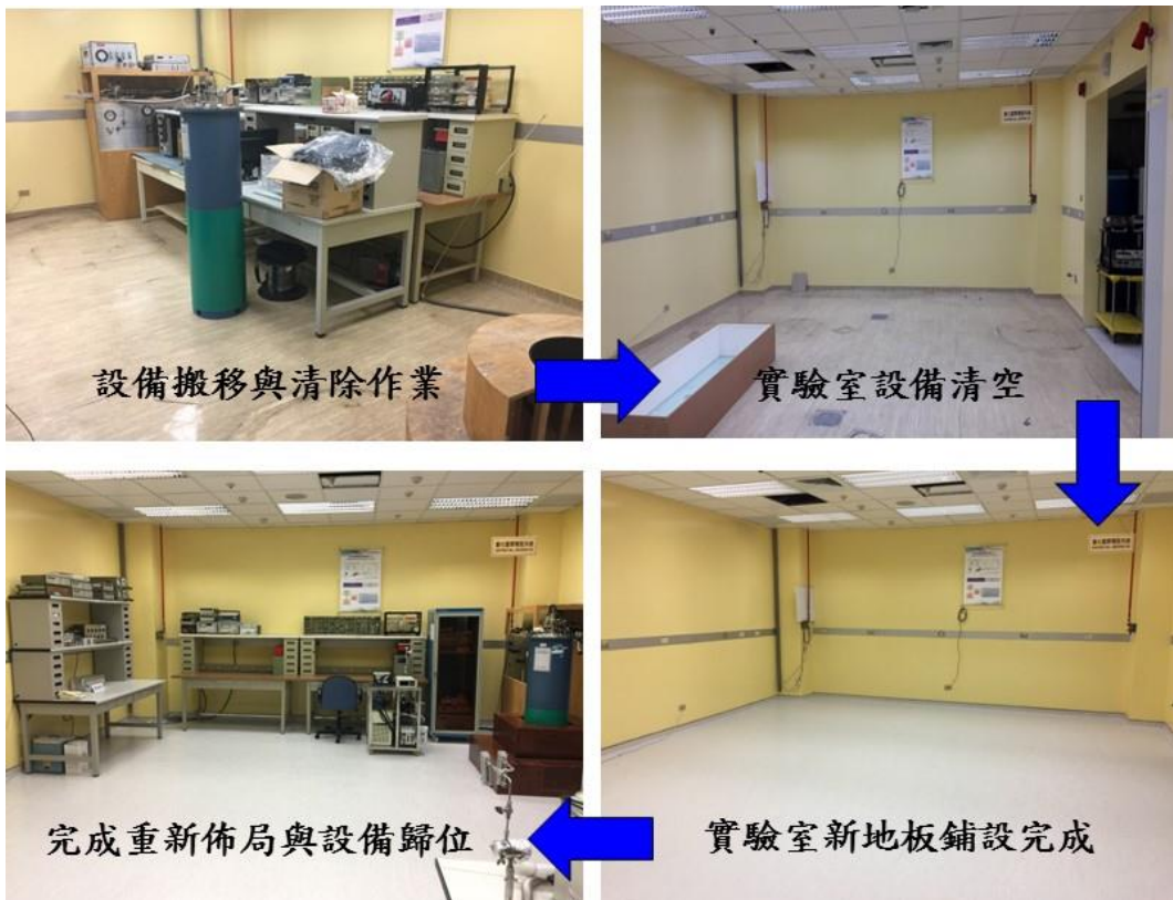
圖 5-3-10、新電流實驗室空間與相關設施改善過程
