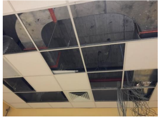
圖 3-2-13、B12 實驗室天花板拆除作業
