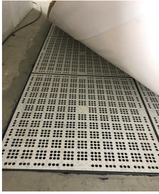
圖 3-2-33、高架地板鋪設
