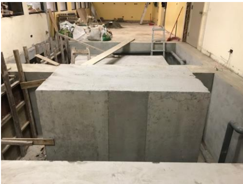
圖 3-2-21、水泥塊灌漿作業
