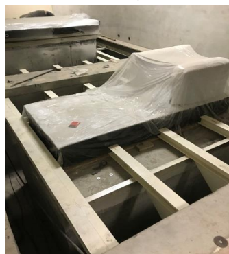
圖 3-2-28、鋪設高架地板支撐鋼樑作業
