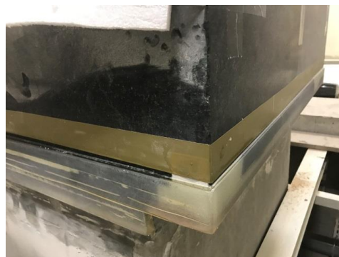
圖 3-2-27、水泥塊與花崗岩樹脂接合補強作業
