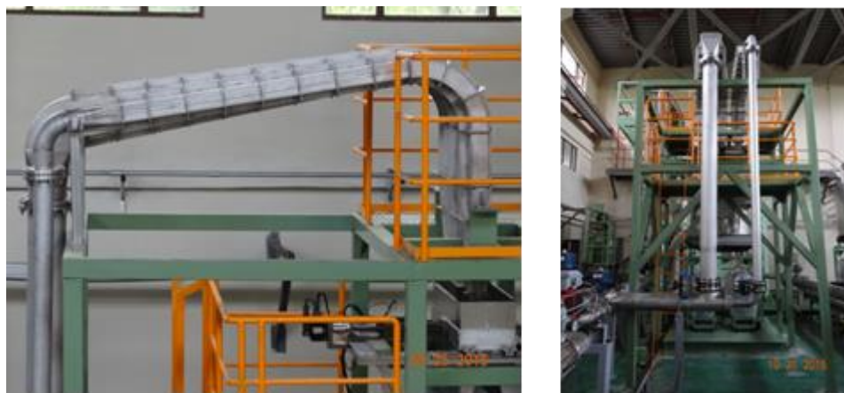
圖 1-4-6、F02 系統雙通道矩形導流噴嘴管完工圖
