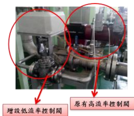
圖1-4-3、F02系統低流率控制閥安裝管路完工圖
